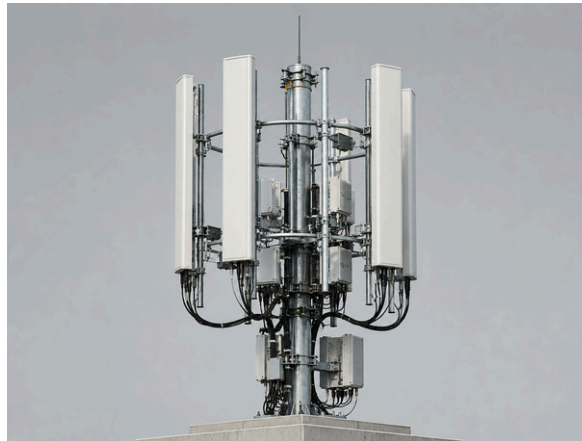
Figura 3.12: Una stazione radio base collega gli smartphone presenti nella cella alla rete dell'operatore.
